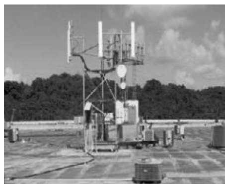
Figura 6.6 – Tipologie di Siti di INWIT: Raw-Land e Roof-Top
